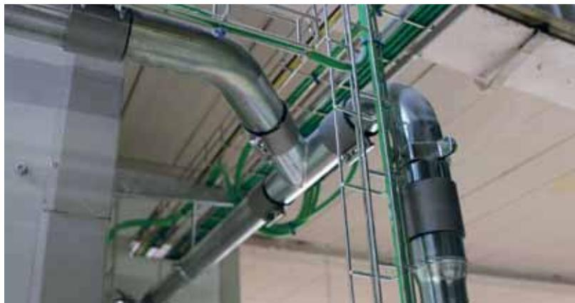
Tubazione antistatica in metallo, fissata in esterno, con speciali manicotti di giunzione
